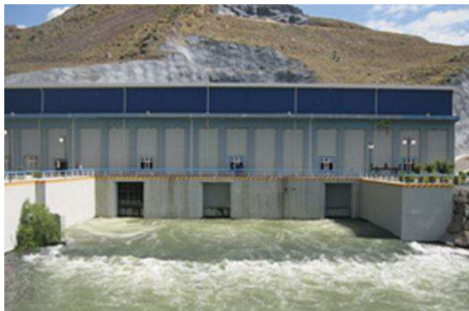
“Arpaçay-1” Su Elektrik Stansiyası
