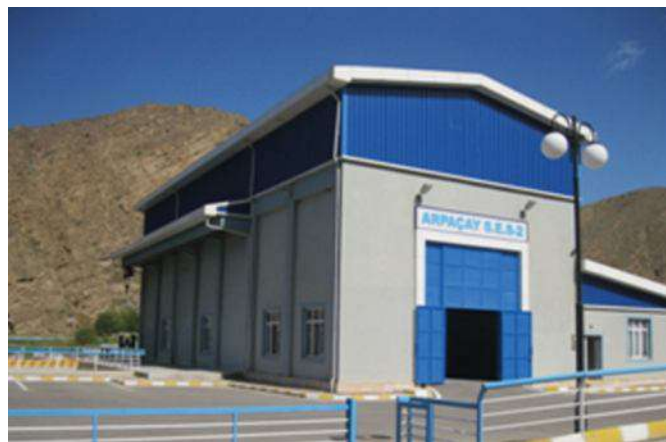
“Arpaçay- 2” Su Elektrik Stansiyası
